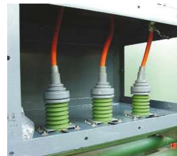
Acoplador Capacitivo Instalado
